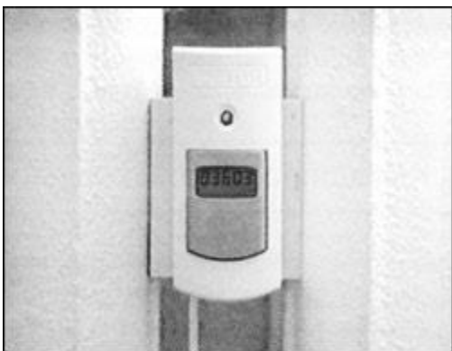
3 pav. Šildymo mokesčių daliklis (šilumos detektorius)
